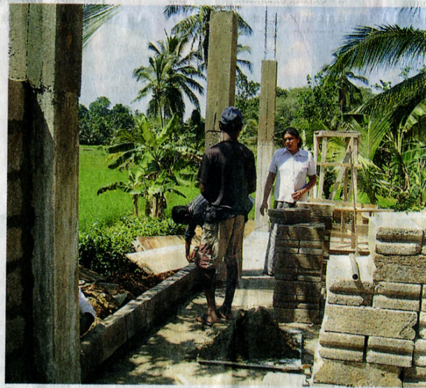
So sah es im Januar noch aus: Im Sommer soll der Neubau des Waisenhaus für Tsunami-Opfer in Mabotuwana im Süden Sri Lankas fertig sein. Foto: ...
